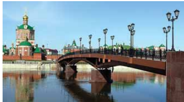
Пешеходный мост в Йошкар-Оле. / Фото с сайта компании «Транс-мост»
